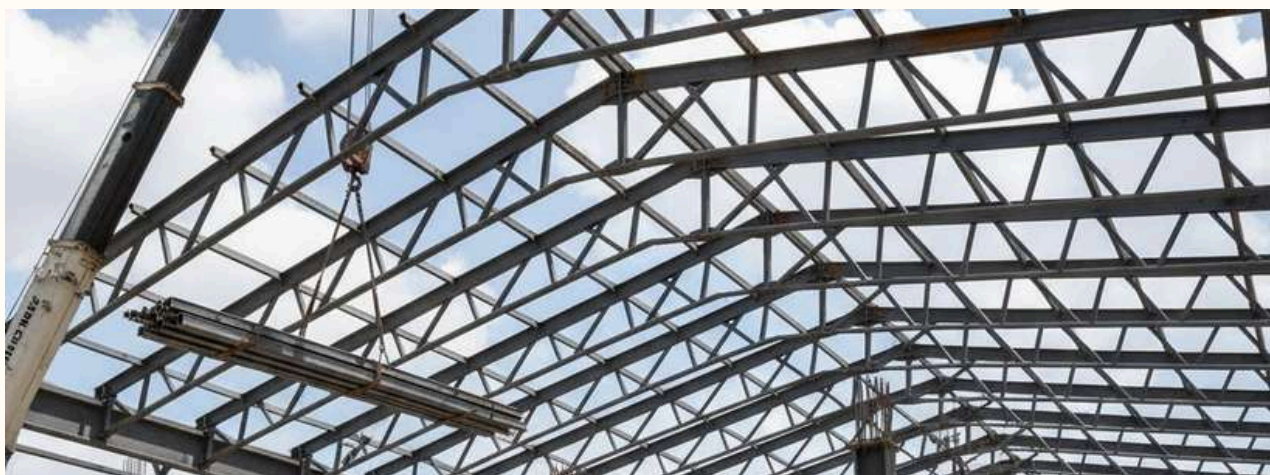
Figura 25 – Cobertura com estrutura metálica. Fonte: Gemini (IA), 2025.
