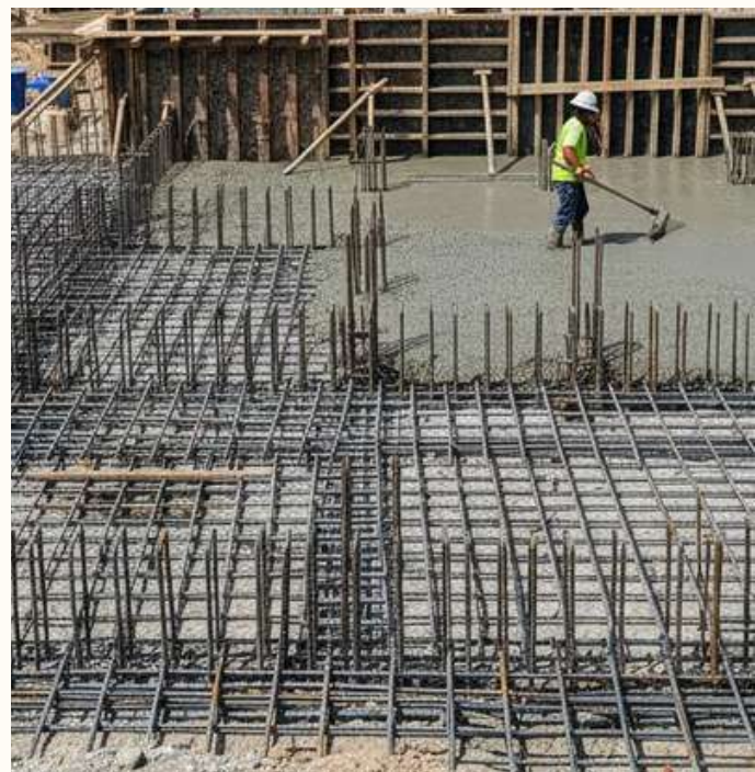
Figura 21 – Concretagem. Fonte: Gemini, 2025.
