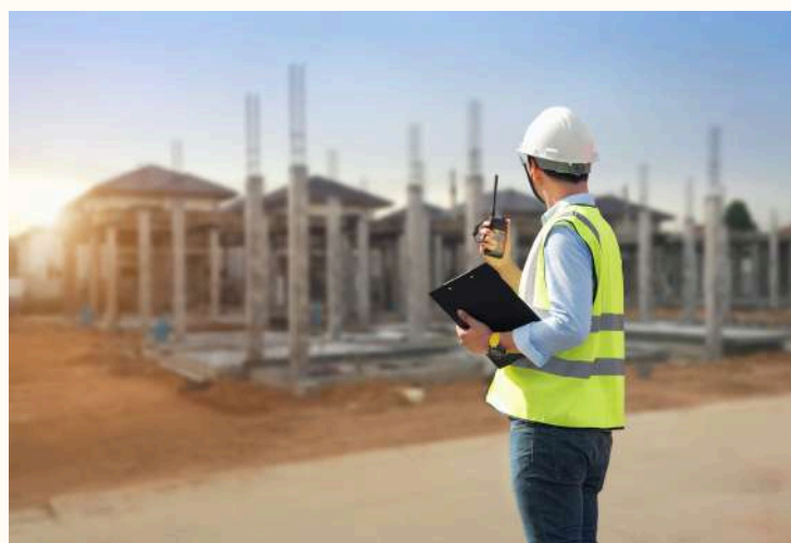
Figura 1 – Obra. Fonte: Canva, 2025.
