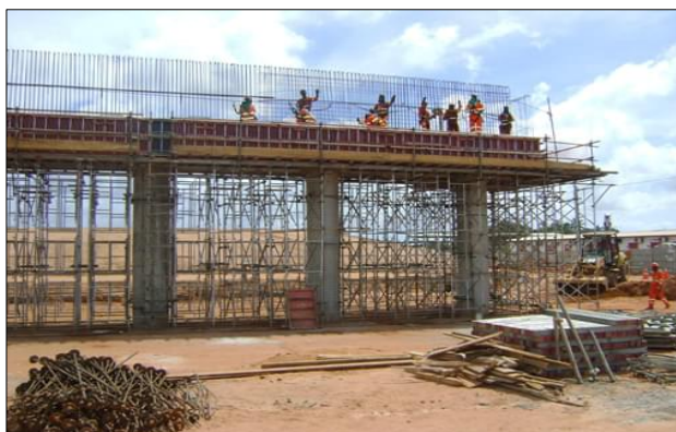
Foto ilustrativa de concretagem de pilares.
