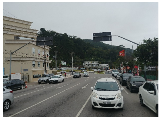
Figura 43 Trecho da Quarta Avenida.
