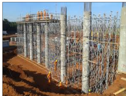
Foto ilustrativa de concretagem de pilares.
