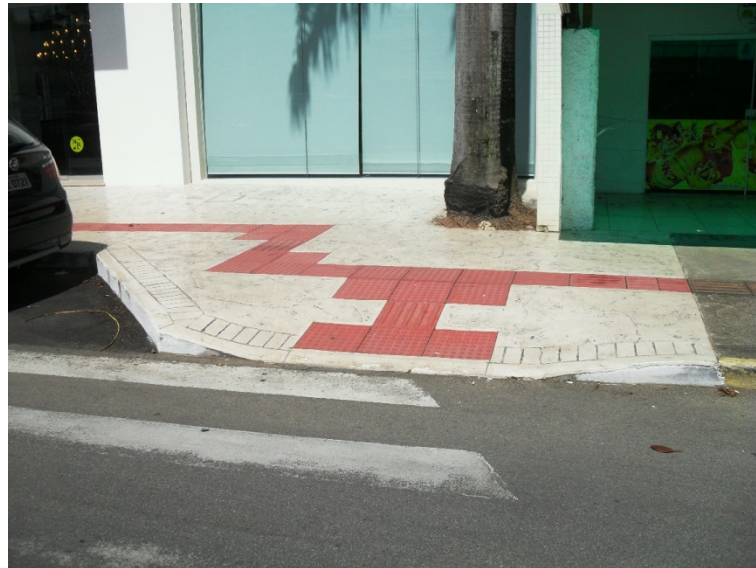
Figura 57 Pavimento típico de concreto estampado “marmorizado”
