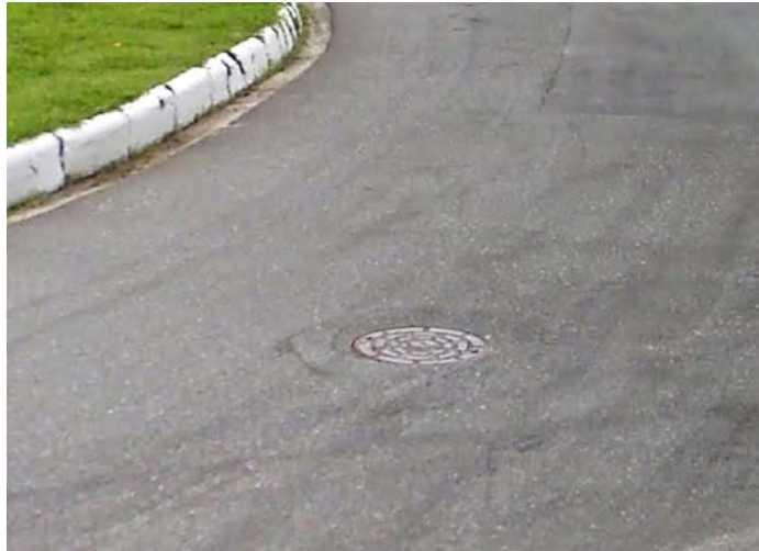
Figura 33 Poço de Visita
