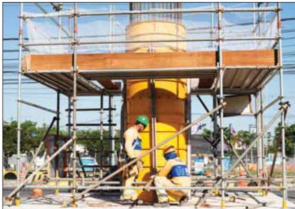
Foto ilustrativa de concretagem de pilares.
