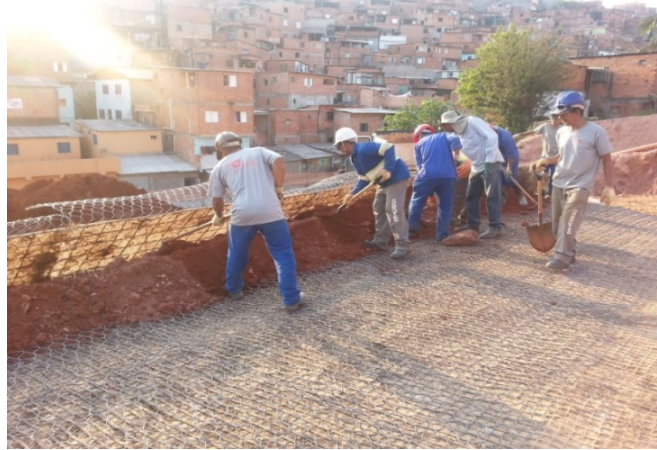
Figura 67 Lançamento e compactação do aterro da área interna do Solo Reforçado Verde.
