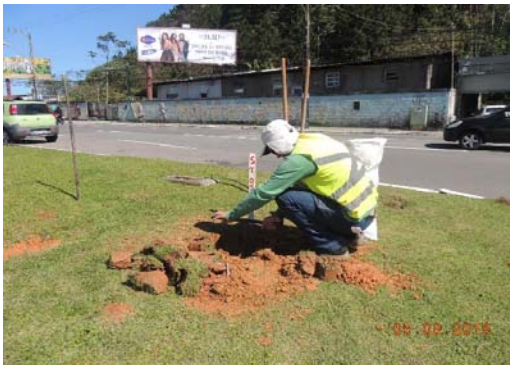
Execução da Sondagem
