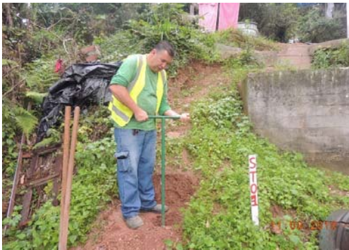
Execução da Sondagem
