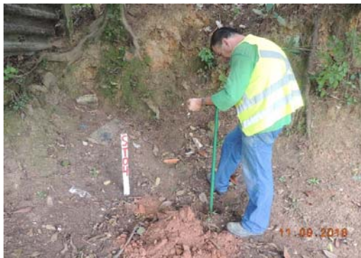
Execução da Sondagem
