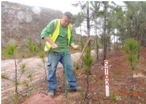
Execução da Sondagem
