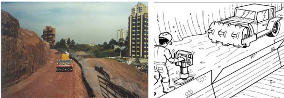
Figura 66 Compactação do aterro respeitando a distância mínima de 1,00 do paramento frontal para equipamentos pesados.
