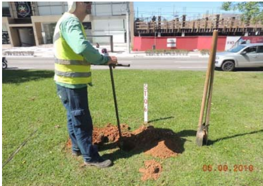
Execução da Sondagem
