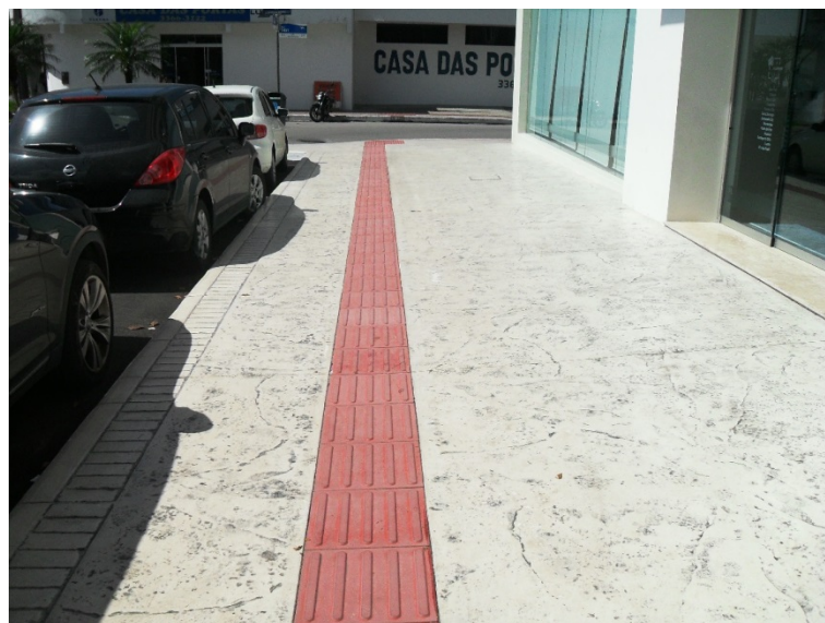
Figura 58 Pavimento típico de concreto estampado “marmorizado”
