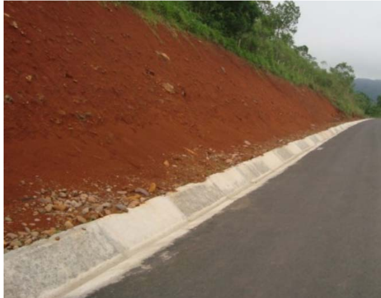
Figura 35 Sarjeta de concreto
