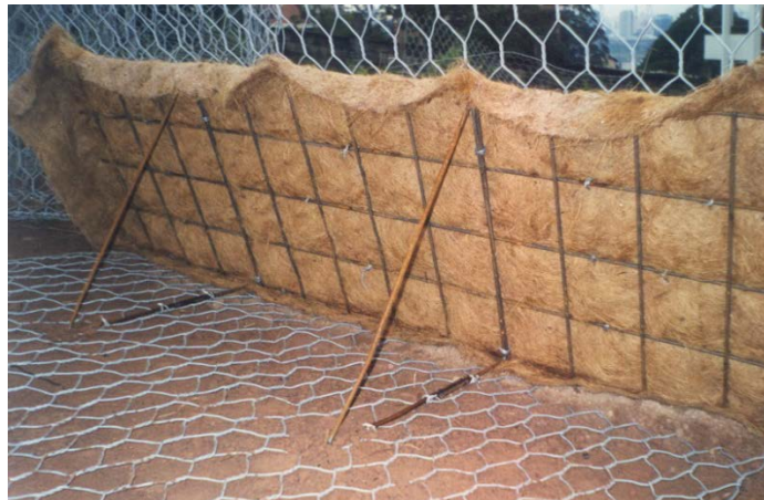
Figura 51 Malha eletrossoldada e triângulos de aço devidamente posicionados.
