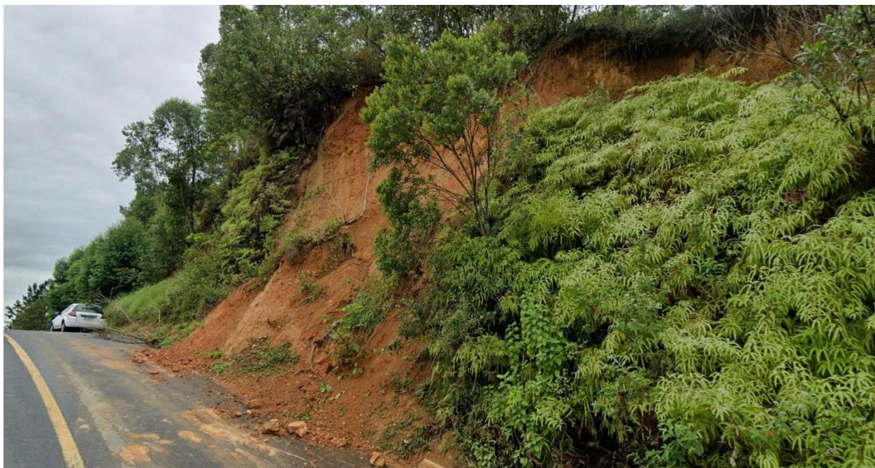
Imagem 04: Talude com ruptura na Rua México
