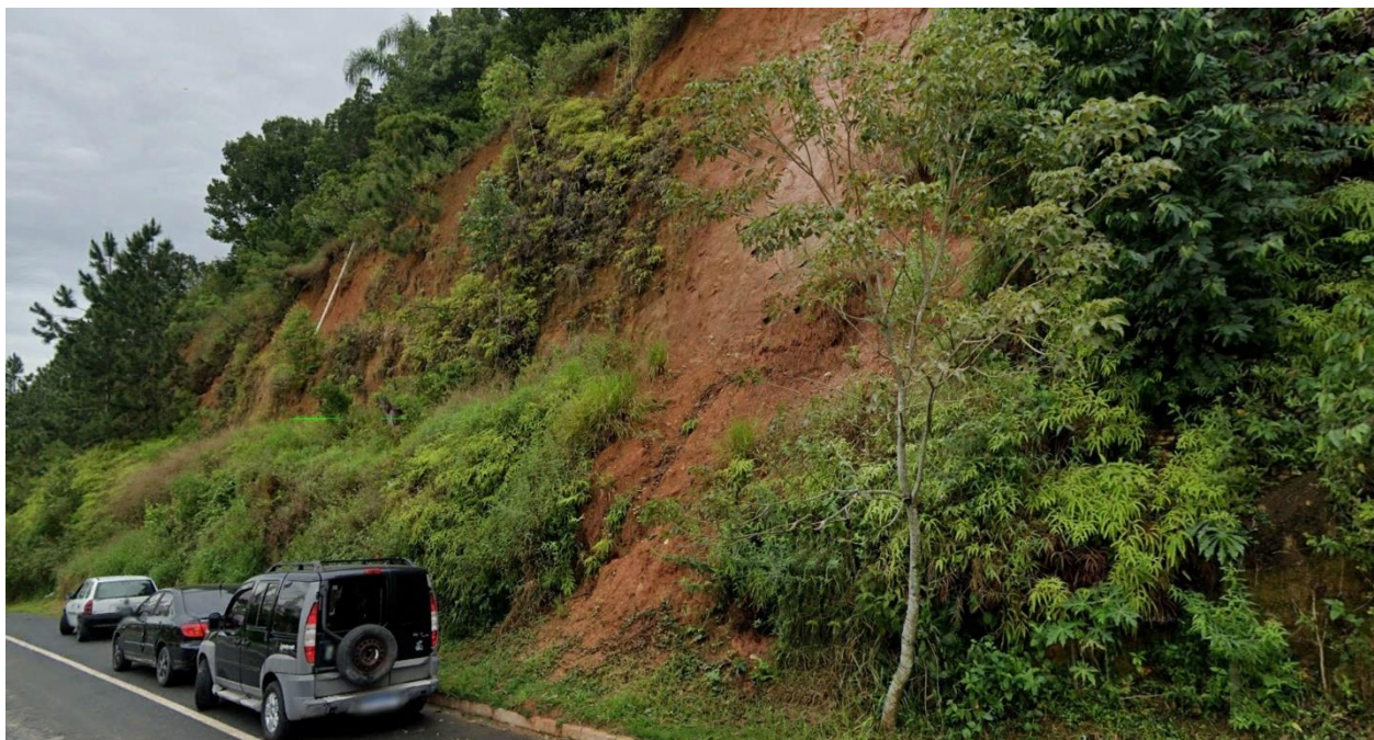
Imagem 03: Talude com ruptura na Rua México
