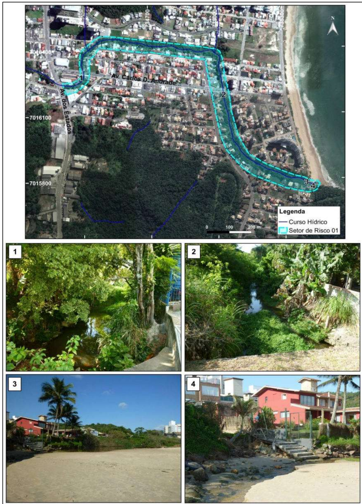
Figura 259 - Localização do Setor de Risco 01 e fotografias dos processos observados na área: (1) e (2) Ocupação das margens do arroio sem respeitar as Áreas de Preservação Permanente. Observa-se ainda que o arroio se encontra bastante obstruído pela vegetação nesses pontos. (3) e (4) Trecho final do Ribeirão Ariribá com indícios de desmoronamento do muro da moradia.
