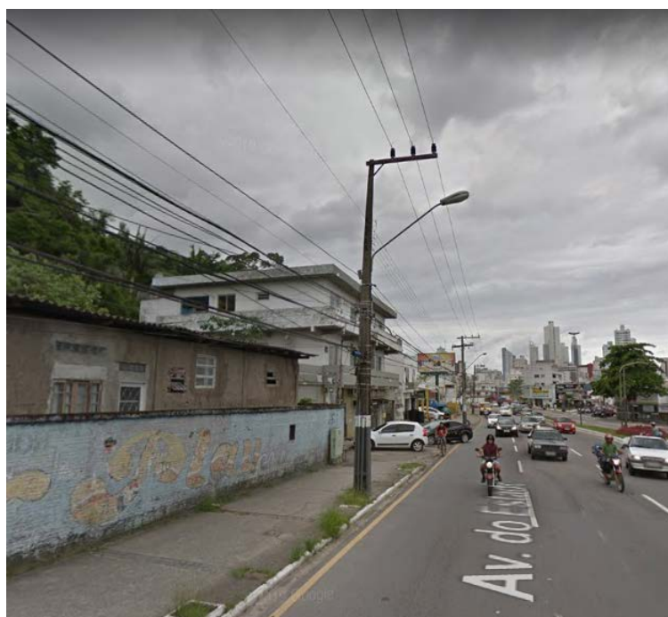
Figura 10 – PR03 - Poste da CELESC relocado devido a adutora projetada estar passando na posição antiga.
