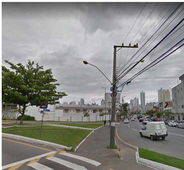
Figura 14 – PR07 - Poste CELESC relocado devido ao novo alinhamento dos postes
