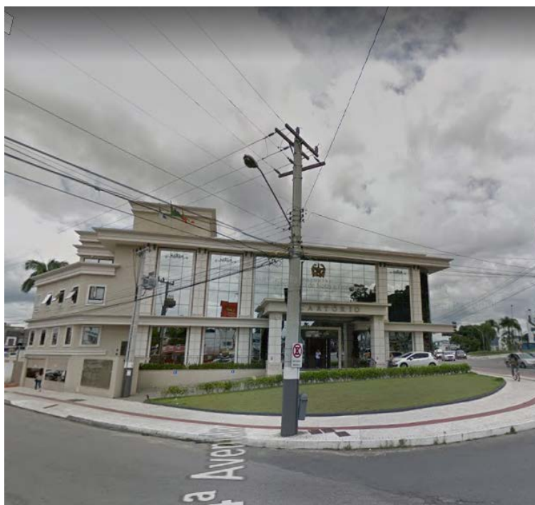
Figura 9 - PR02 – Poste da CELESC relocado por estar em cima da pista projetada
