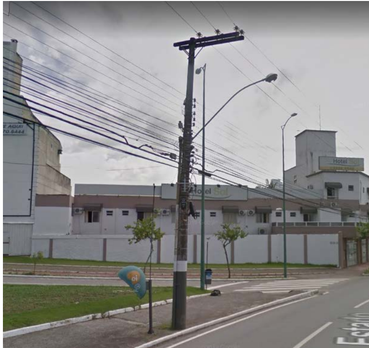
Figura 15 - PR08 – Poste CELESC relocado devido ao novo alinhamento dos postes
