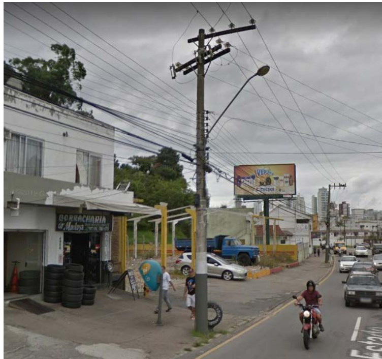
Figura 11 – PR04 - Poste da CELESC relocado devido a adutora projetada estar passando na posição antiga.
