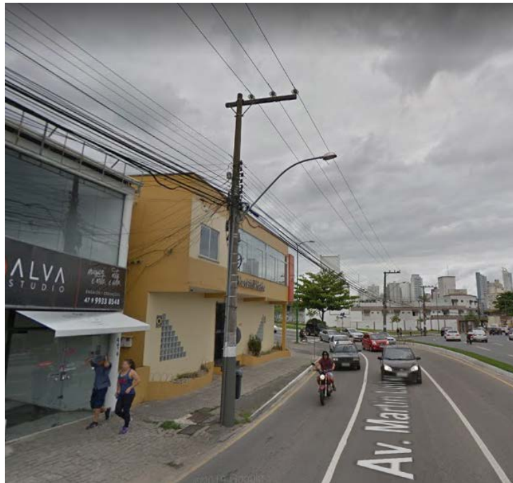
Figura 13 - PR06 – Poste CELESC relocado devido ao novo alinhamento dos postes
