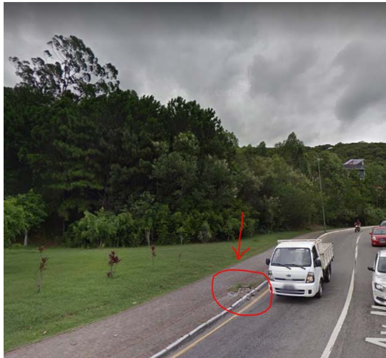
Figura 7 - PRR07 – Poste decorativo removido por estar sem função.
