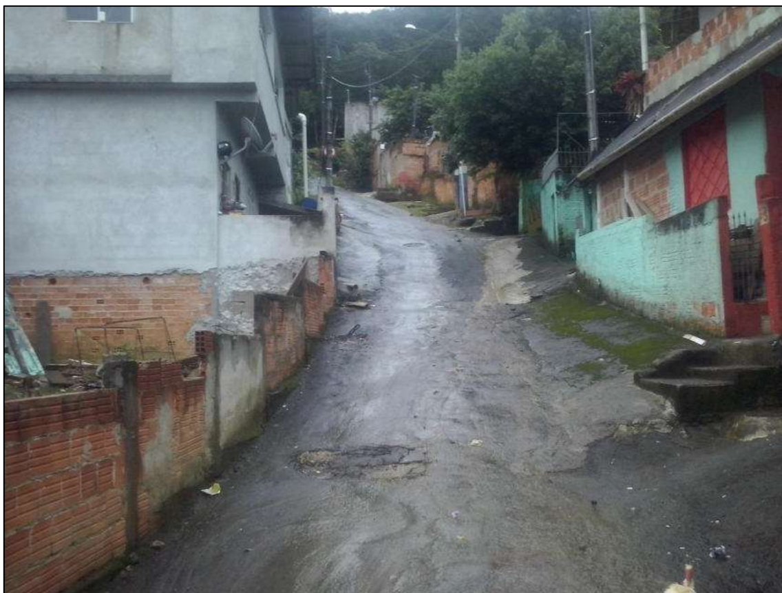
Figura 407 - Pista escorregadia na rua porto Rico, núcleo 5.
