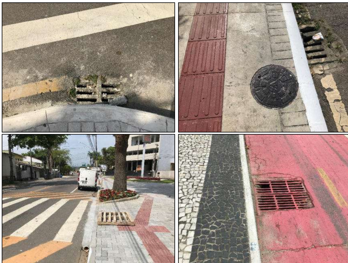
Figura 395 – Instrumentos de drenagem (bocas de lobo).
