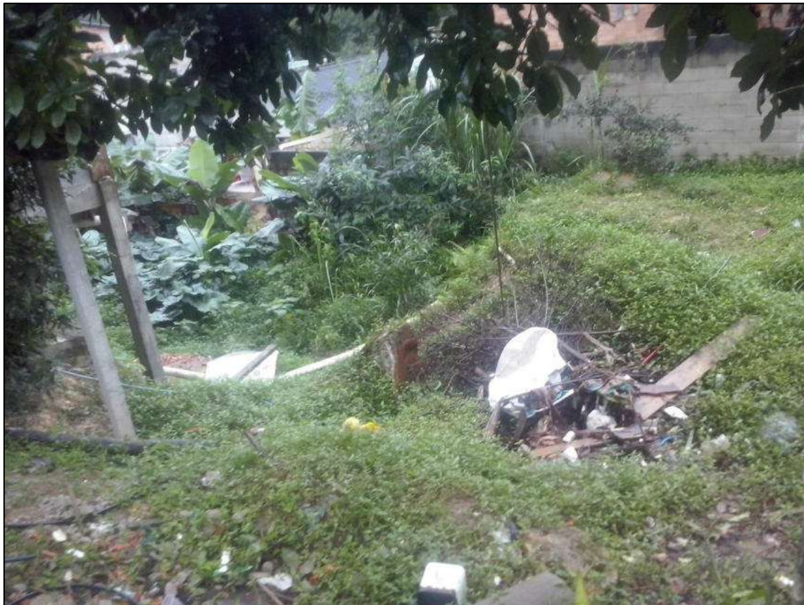
Figura 403 - Vala onde havia acúmulo de esgoto na rua Porto Rico.
