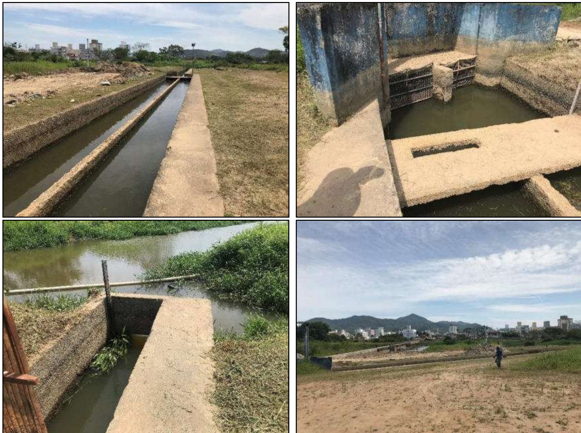
Figura 372 – Captação de água – Balneário Camboriú.
