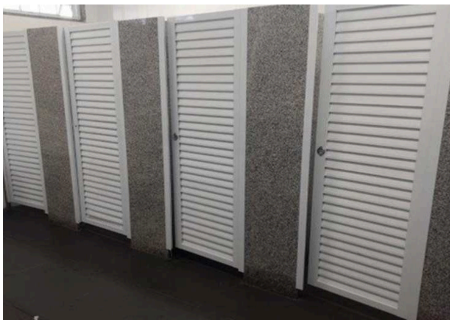
DIVISÓRIAS SANITÁRIOS DIVISÓRIA DE GRANITO CINZA ANDORINHA PORTAS COM VENEZIANA VENTILADA
