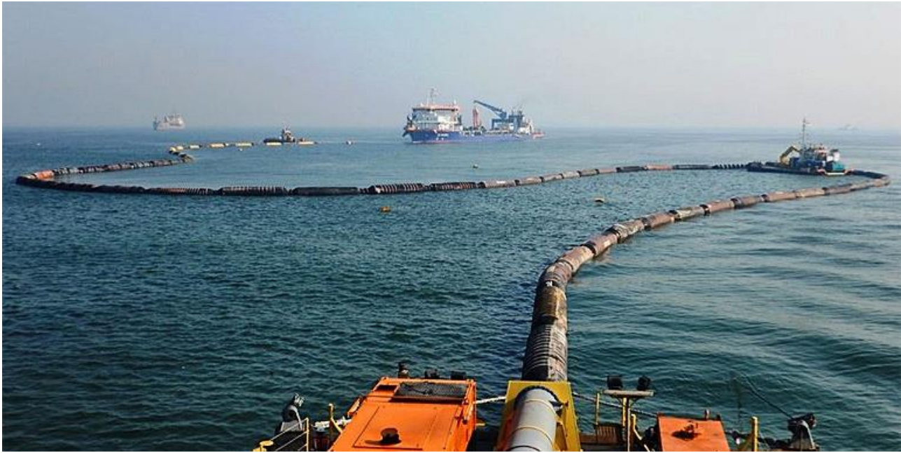
Linhas de recalque (pipe line) flutuante para bombeamento da areia da draga em direção a praia,
