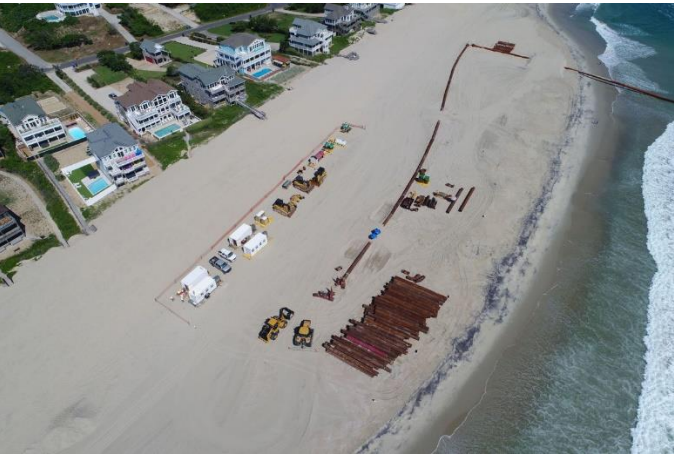
Linhas de recalque (pipe line) em terra para distribuição da areia na praia.
