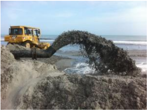
Linhas de recalque (pipe line) em terra para distribuição da areia na praia.
