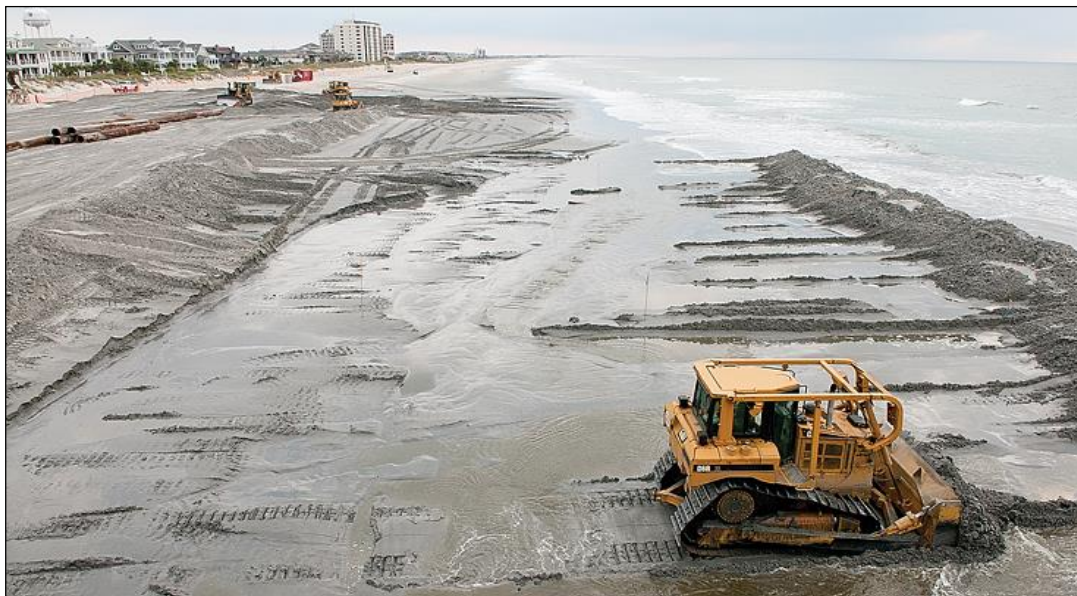
Figura 60 – Construção das Células de Acumulação (Fonte: Internet)
