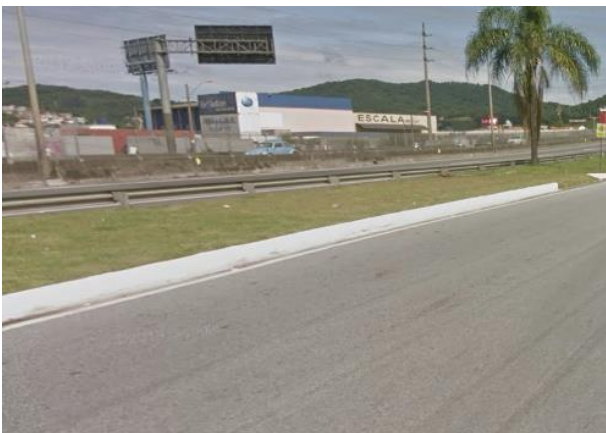
Figura 12.1 - Meio fio existente
