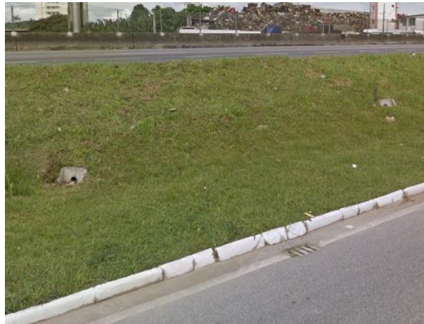
Figura 12.3 - Boca de saída de dreno e Boca de Lobo com Grelha
