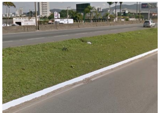
Figura 12.2 - Boca de Lobo com Grelha
