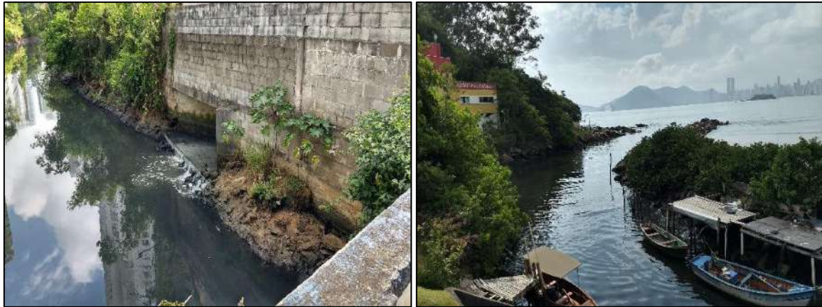
Figura 112 – Aspecto do leito do Rio Marambaia, sofrendo com o despejo de esgotos domésticos não tratados até sua foz, no oceano.
