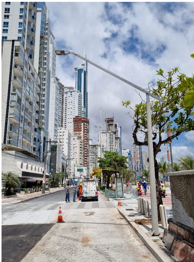
Detalhes do poste via
