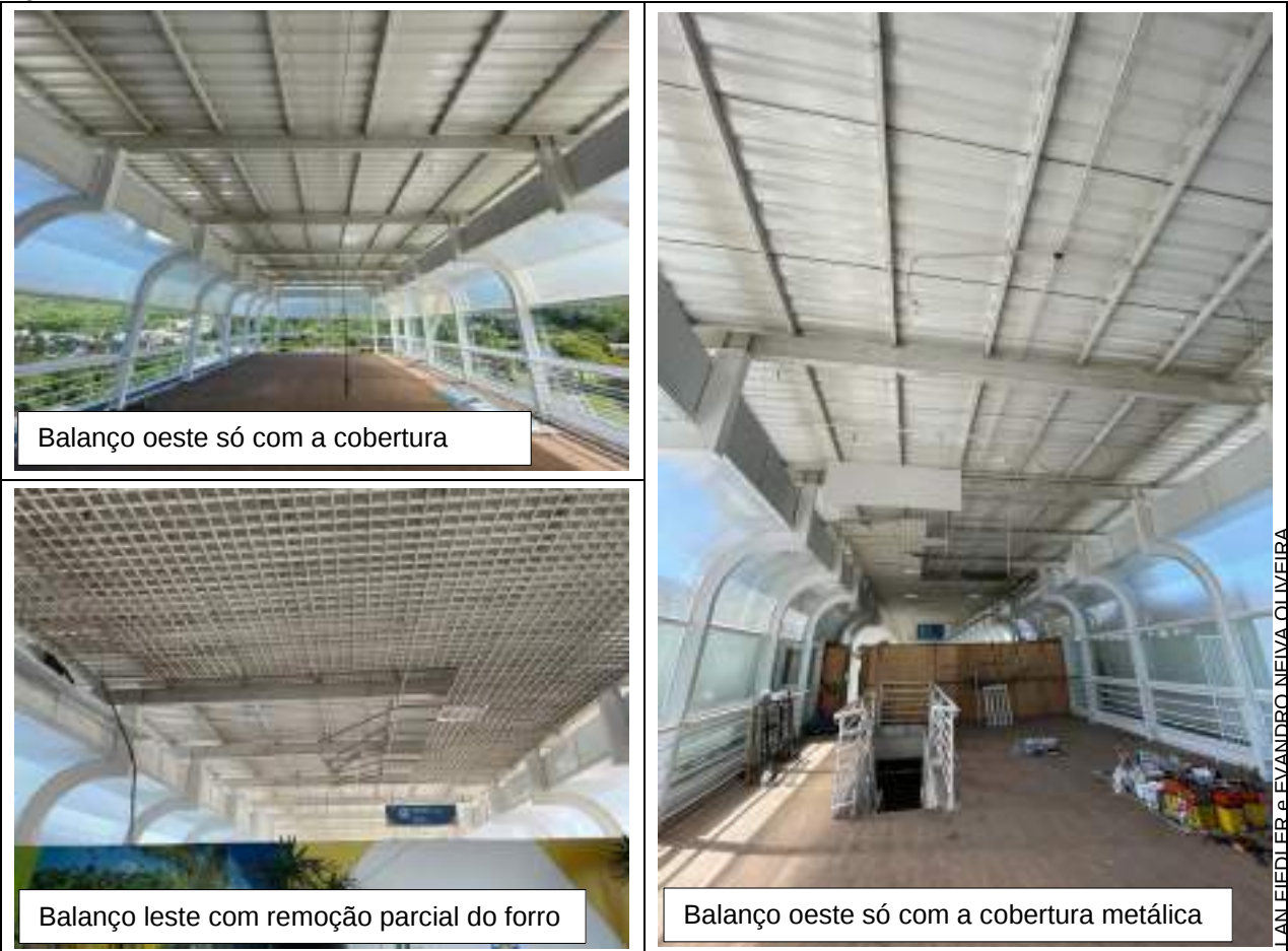
Figura 13 – Reforma dos elementos do teto
