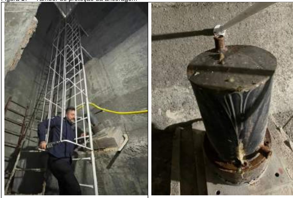
Figura 17 – Tambor de proteção da ancoragem
