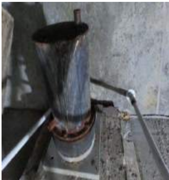
VISTA DO INTERIOR DA TORRE COM A ANCORAGEM FIXA JÁ APRESENTANDO ALTO GRAU DE OXIDAÇÃO COM O CAPÔ INCLUSIVE MOSTRANDO SINAIS DE CORROSÃO.
