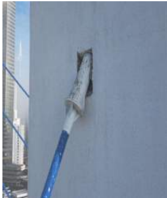
VISTA DO ACABAMENTO E TUBO FORMA DO ESTAI E4 P2-JUSANTE BARRA, NÃO SE PERCEBE NENHUM SINAL DE OXIDAÇÃO.
