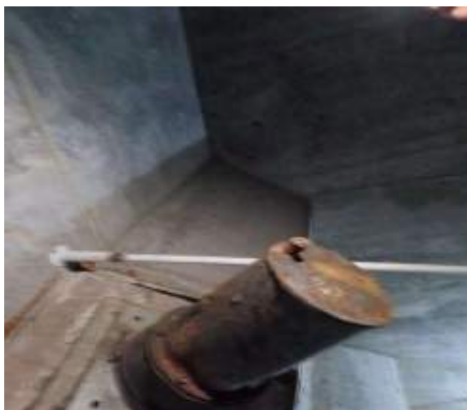
VISTA DO INTERIOR DA TORRE COM A ANCORAGEM FIXA JÁ APRESENTANDO ALTO GRAU DE OXIDAÇÃO COM O CAPÔ INCLUSIVE MOSTRANDO SINAIS DE CORROSÃO.
