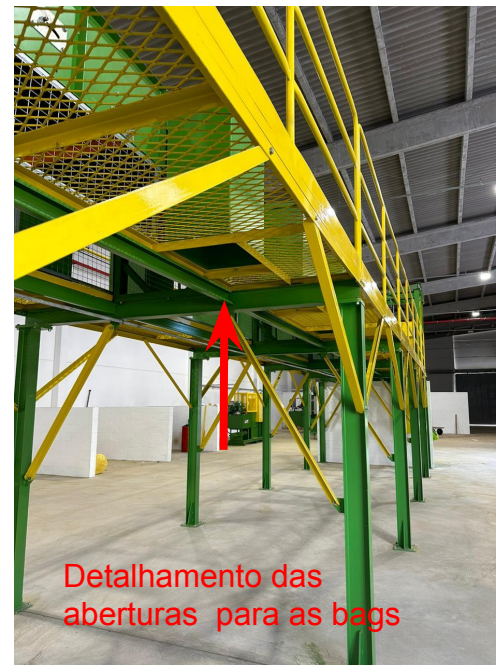
Figura 07: Abertura inferior para a disposição do material em bags.
