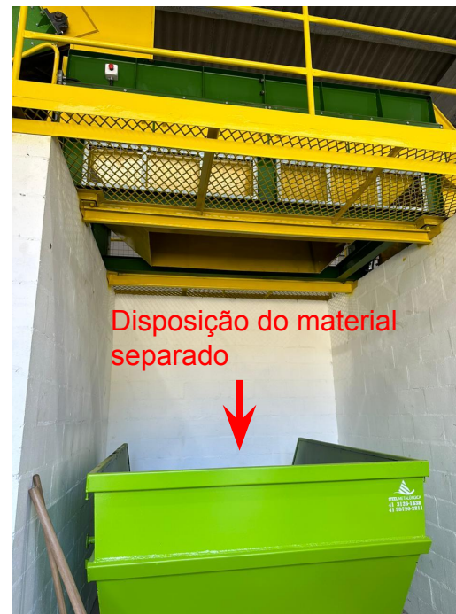
Figura 05: Separação de vidros e materiais finos com baixo valor agregado.
