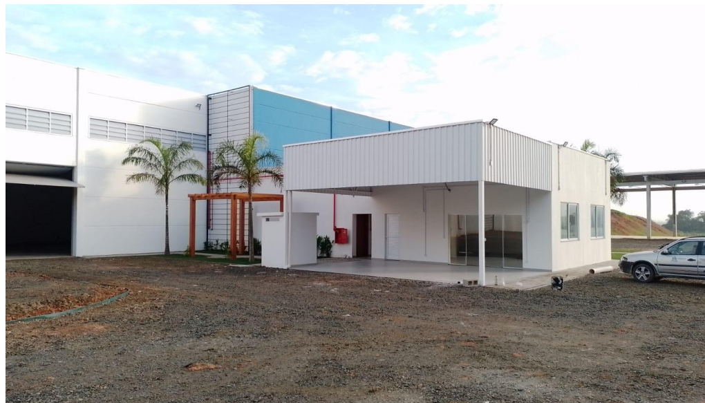
Figura 04: Pátio de manobras e entrada principal do CVM.
