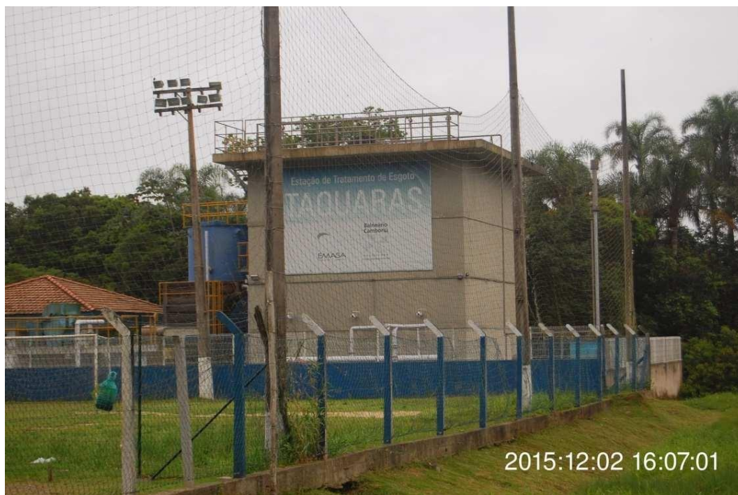
Figura 53: Vista da estação de tratamento de efluentes que foi desativada em Taquaras. Fonte: Ecolibra, 2018.
