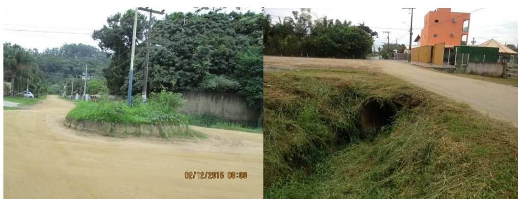
Figura 243: Exemplos de ausência de sinalização em cruzamentos. Fonte: Ecolibra, 2018.
