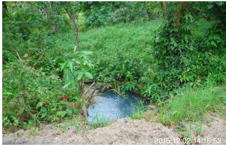
Figura 72: Vista de despejo pontual clandestino de efluente sanitário. Fonte: Ecolibra, 2018.
