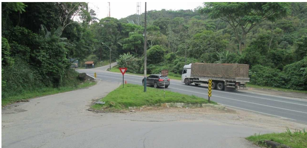
Figura 239: Acesso à APA pela BR-101. Detalhe do acesso pela Rua Ver. Domingos Fonseca pela localidade do Estaleiro e acesso à comunidade quilombola. Fonte: Ecolibra, 2018.
