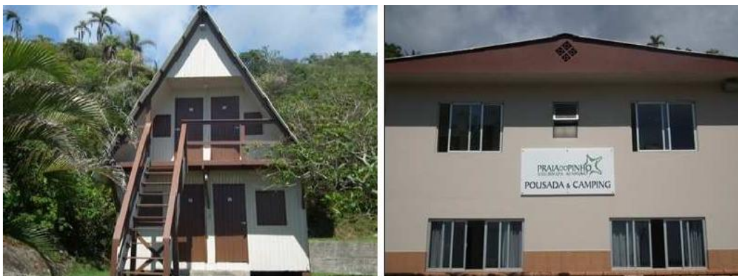
Figura 214: Pousada localizada na Praia do Pinho. Fonte: http://praiadopinho.com.br/pt/Camping ; Ecolibra, 2018.
