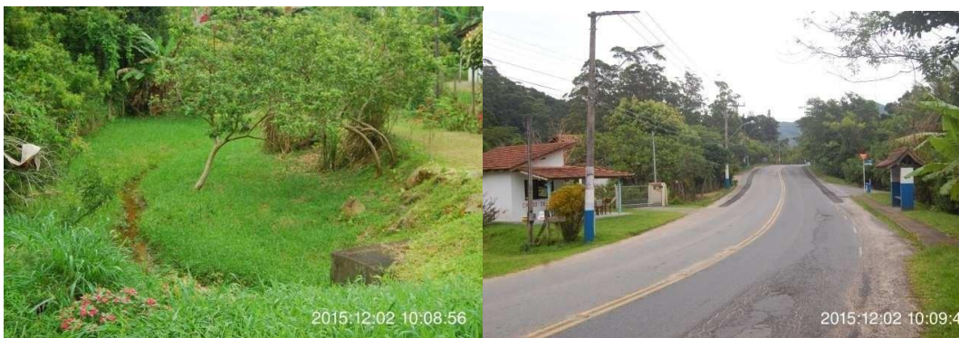
Figura 262: Área problema localizada na Rodovia Interpraias esquina com Rua João Venâncio Ramos na Praia do Estaleiro. Fonte: Ecolibra, 2018.
