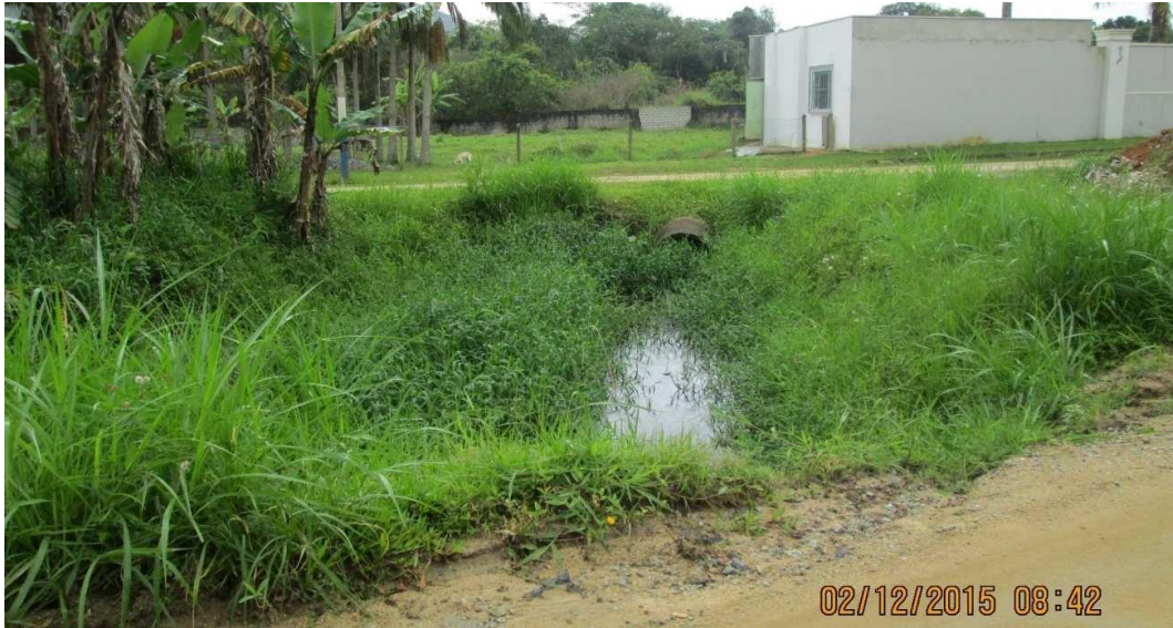
Figura 261: Área problema junto a Rua Antônio Torquato. Fontes: PMSB/SC, 2012 e Ecolibra, 2018.
