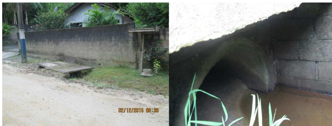
Figura 242: Danos na infraestrutura de drenagem de vias sem pavimentação adequada (esquerda) e assoreamento destas estruturas (direita). Fonte: Ecolibra, 2018.
