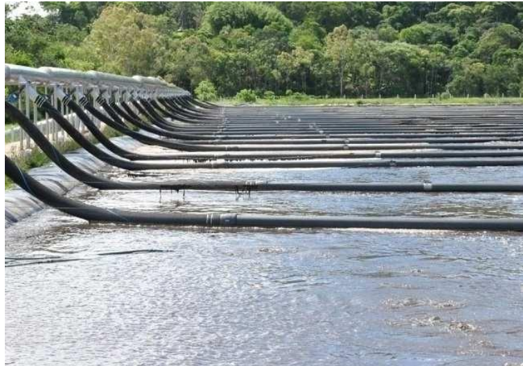
Figura 257: Estação de Tratamento de Esgotos da Nova Esperança. Fonte: EMASA e Ecolibra, 2018.
