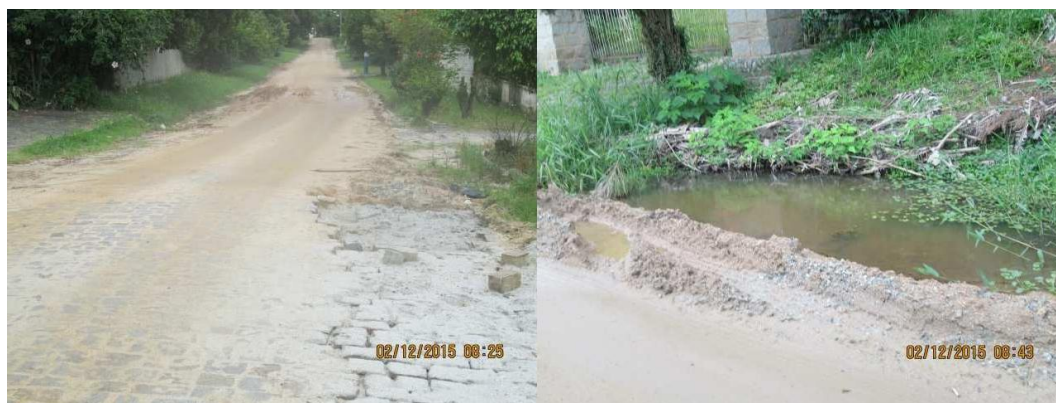
Figura 241: Situação de vias sem pavimentação adequada. Fonte: Ecolibra, 2018.
