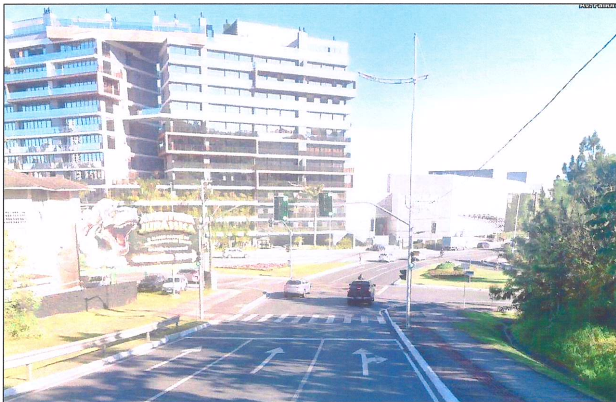
Figura 11: Trecho da Avenida Panorâmica
